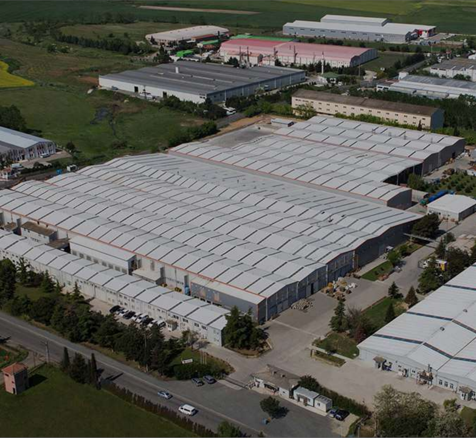
Termo Teknik Çorlu Üretim Tesisleri
