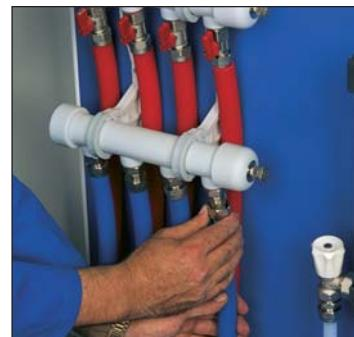
6- Kesilen uç kollektör bağlantı seti ile kollektöre bağlanır.
