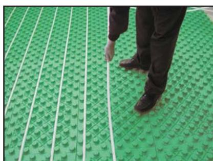
2- Yerden uygulama projesinde, mekanın ısı ihtiyacına göre kullanılacak boru uzunluğu, boru aralıkları ve döşeme şekli daha önceden planlanmış olmalıdır. Boru, kollektöre bağlanması için gerekli mesafeleri her iki uçtan bırakacak şekilde, panel üzerine döşenmeye başlanır.
