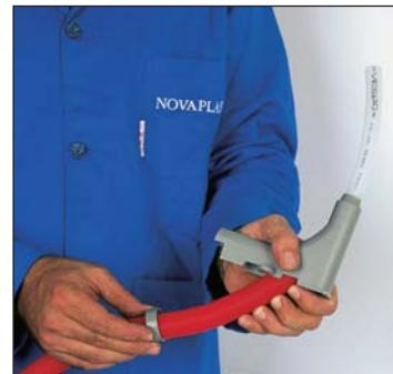
2- Kesilen boru köşe düzeltici ayak içinden geçirilir.
